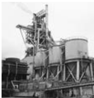
水砕スラグ製造設備（ラサ・システム）
